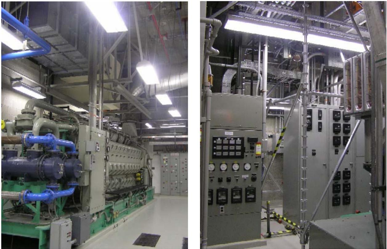
Figura D.2 – Dettagli di generatori diesel per impianti nucleari [3]
