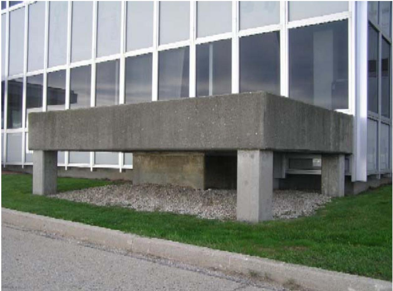
Figura D.3 – Scudo di protezione da missili generati da tornado per la condotta di aspirazione [3]
