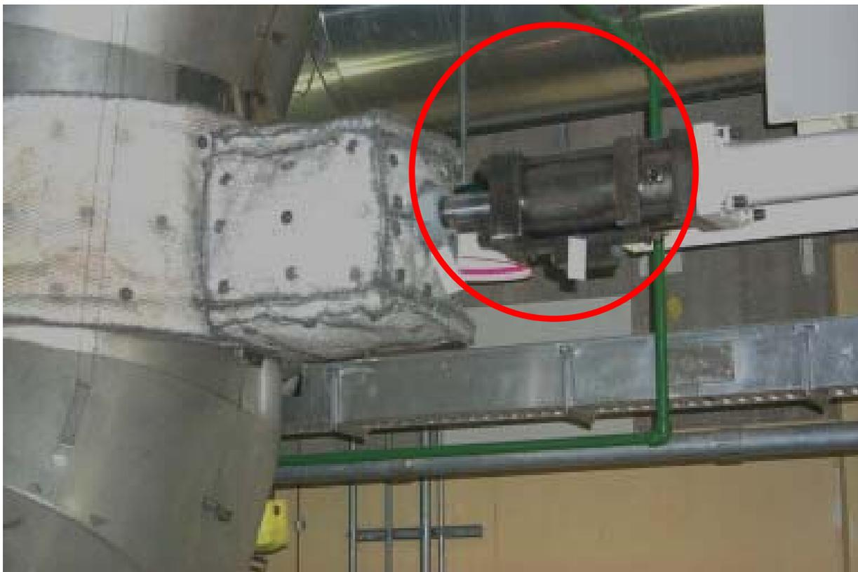
Figura 2.2 – Dettaglio di uno *snubber* per la limitazione delle sollecitazioni sismiche
